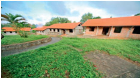
Quatre nouvelles maisons en construction
